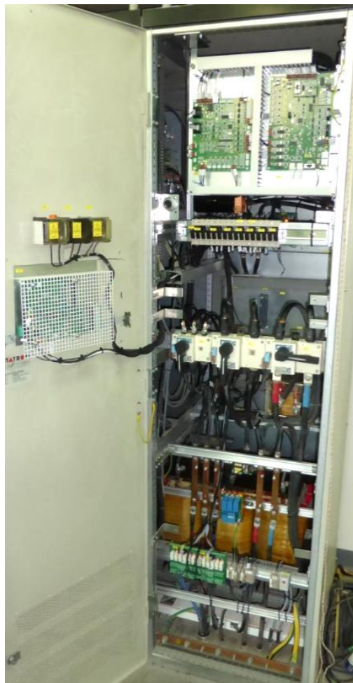
BDTe nach Umbau
