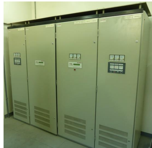
Schränke vor Umbau (wurden behalten)
