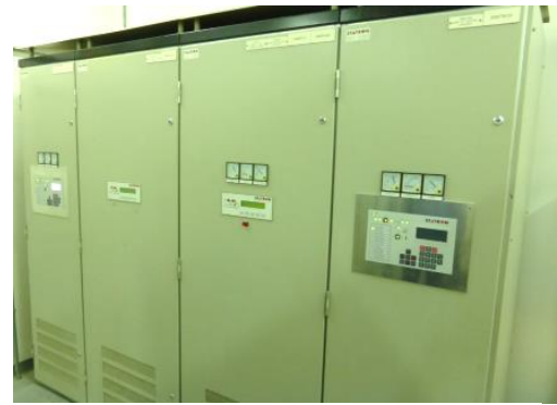
Runderneuertes Gleichrichtersystem
