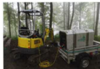
Einsatz des Butler S auf einem PW-Anhänger im schwer zugänglichen Gelände.
